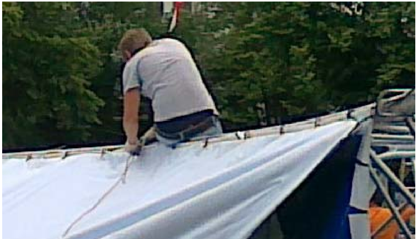
Рис. 12. Примеры балочного крепления монтажных частей мембраны.
