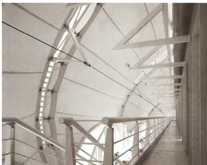
Рис. 16. Узлы натяжения катенарных кромок на зарубежных конструкциях.
