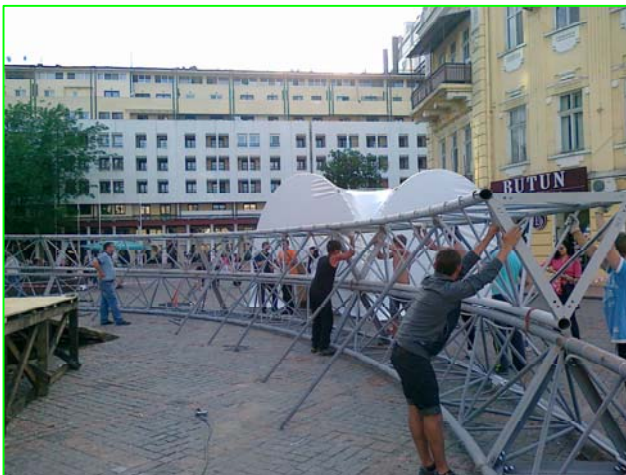
Рис. 69. Центральные арки в проектном положении.
